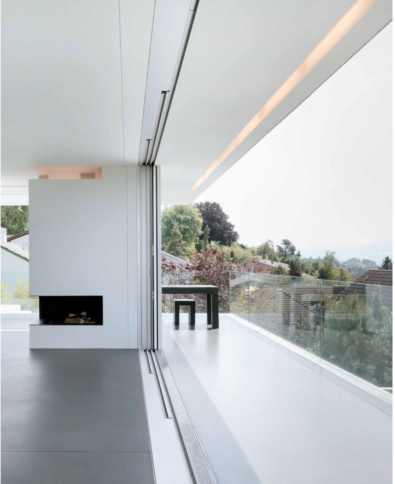
Mit der Pocket-Lösung von Sky-Frame wird das komplette Öffnen des Raums möglich, ohne sichtbare Flügel. Die Schiebeelemente werden unsichtbar in einer Nische versteckt. Es bleiben weiterhin Features wie Drive (mit elektrischem Antrieb) möglich.
