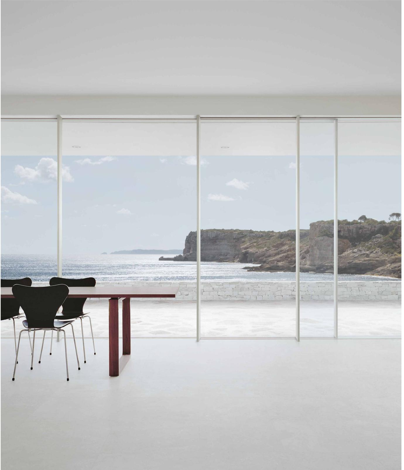
Das Sky-Frame System wird durch den filigranen Pfosten, mit einer minimalen Ansichtsbreite von nur 30 mm, ergänzt. Erhältlich in drei Bautiefen (66/90/110mm) und für höhere statische Anforderungen mit bis zu vier Stahl-Einschieblingen verstärkbar. Rahmenlose Festverglasungen können so grossflächig mit Schiebefenstern kombiniert werden und bilden eine flächenbündige, durchgehende Glasmembran.
