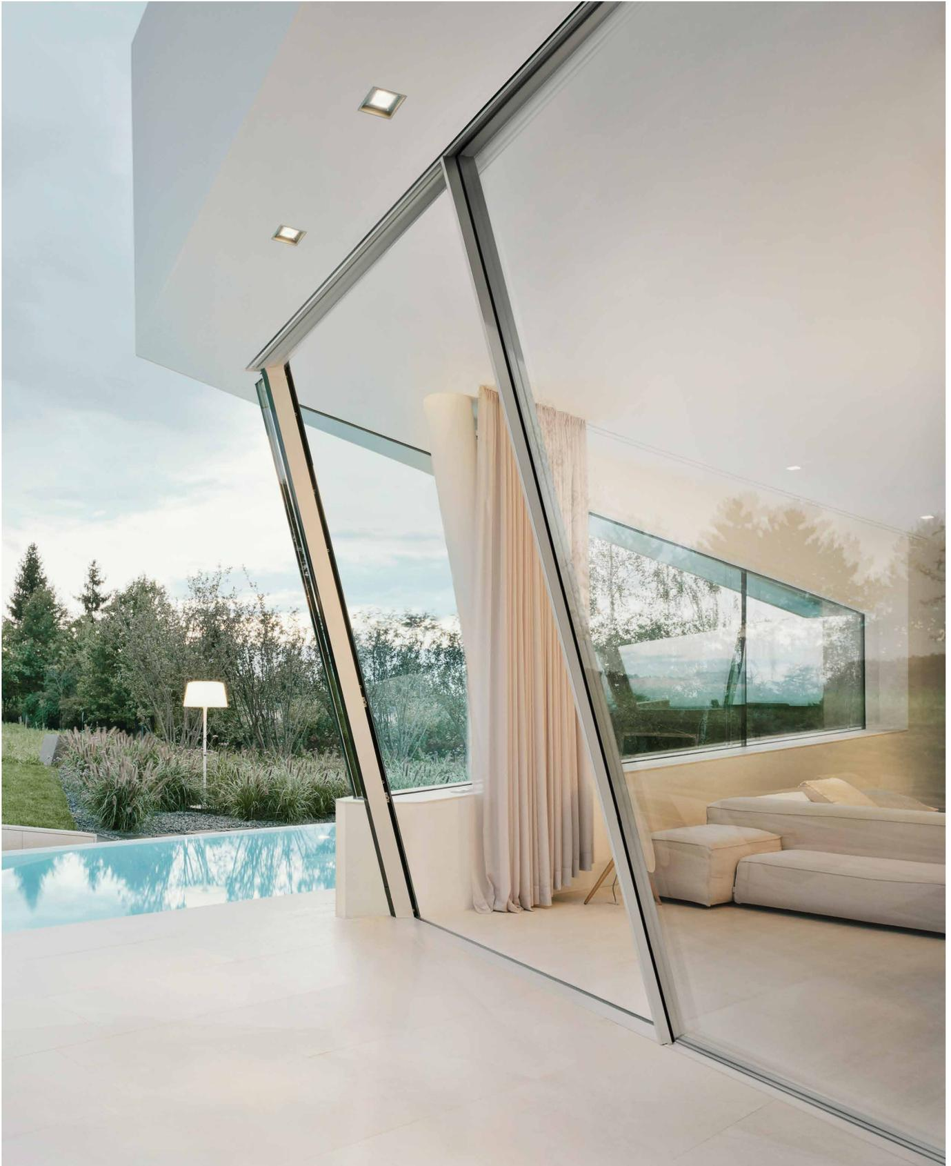
Die Schiebefenster neigen sich bei Slope bis zu  $20^\circ$  aus der Vertikalen wahlweise in den Wohnraum hinein oder aus der Fassade heraus. Das System erfüllt alle Standards von Sky-Frame und ermöglicht eine besondere Raumgeometrie. Die spezielle Lagerung gleicht sämtliche vertikalen und horizontalen Kräfte aus und sorgt so für leichte Laufeigenschaften. Die Systementwässerung funktioniert auch entgegen der Neigung und erfüllt alle Ansprüche an die Schlagregendichtheit.
