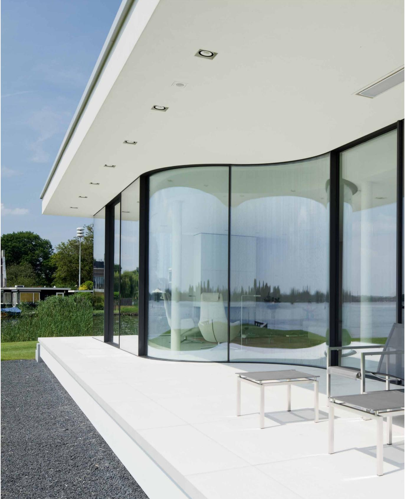
Die gebogenen Schiebeelemente von Sky-Frame Arc laufen leicht um die Kurve und verleihen dem Wohnraum organische Linien. Die gewölbten Verglasungen lassen sich mit leichter Laufeigenschaft bewegen und auf Wunsch auch mit elektrischem Antrieb ausstatten. Das System erfüllt alle Standards von Sky-Frame und bietet als Element zeitgenössischer Architektur zusätzliche Gestaltungsfreiheit.
