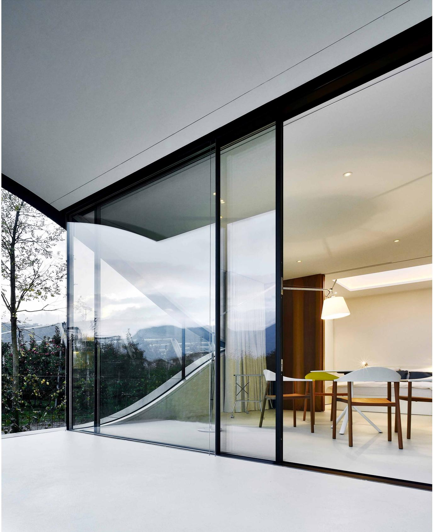
Mit dem elektrischen Antrieb lassen sich bis zu 6 (3+3) Schiebeelemente mit nur einem Knopfdruck bequem und praktisch geräuschlos öffnen und schliessen. Der Antrieb ist unsichtbar in das Deckenprofil integriert und erlaubt das automatisierte Bewegen von Fensterfronten.
